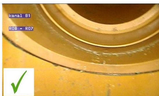
Obr.3 Správně umístěné těsnění
