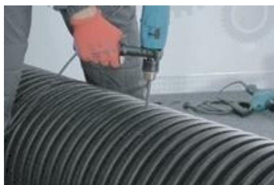
Vyvrtajte otvor o průměru 10 mm
